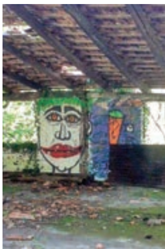
La tettoia in stato di degrado
